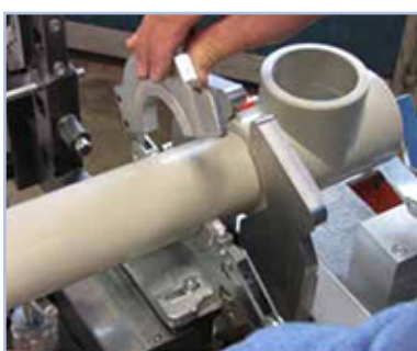
Monter røret i sveisemaskinen etter maskinens anvisninger.
